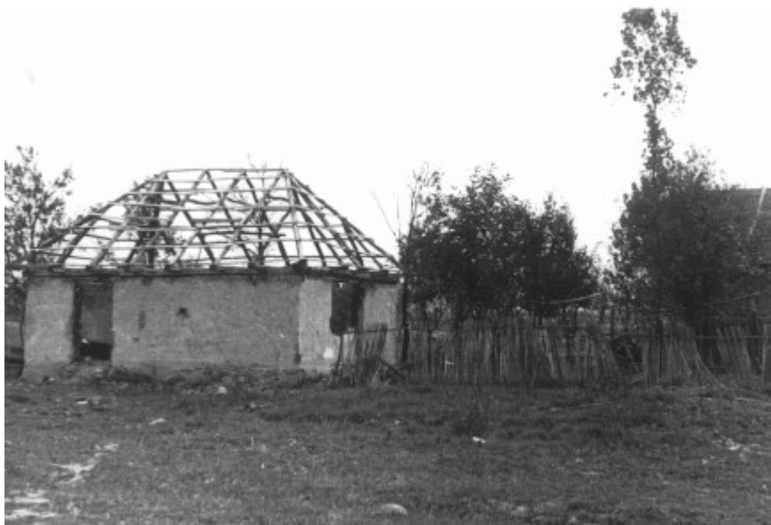
Foto 9. Racșa: casă în reconstrucție
